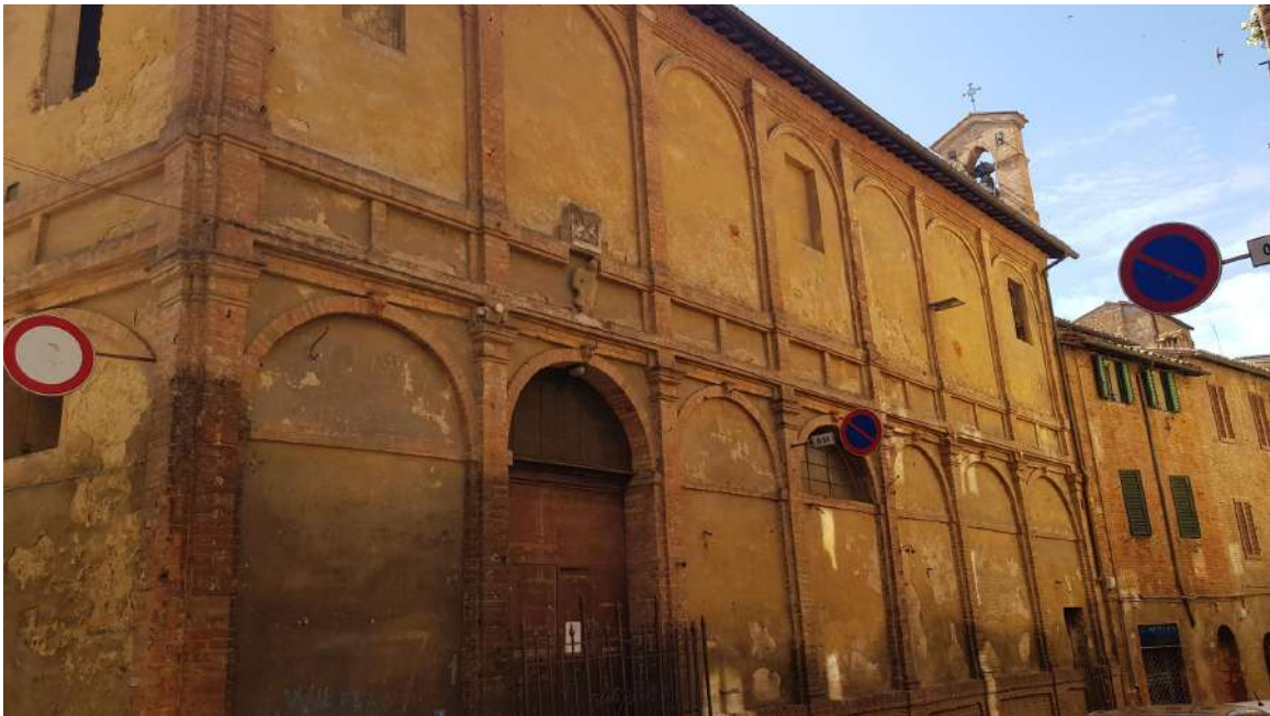
Facciata ad arcate tamponate
